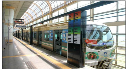
그림 3. RPSD 설치 현황(대구 도시철도 문양역) Fig. 3. RPSD at Muryang Station in Daegu
